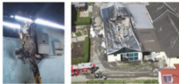
Bild: Brand durch Installationsfehler bei DC-Trennschalter Brandausbreitung unter dem Blechdach
