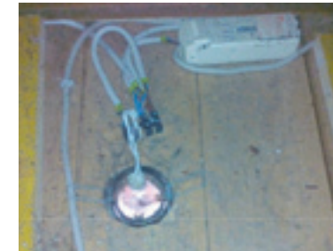
Bild 1: Brandgefahr Halogenleuchten
