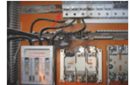
Bild 2: Mangelhafte Verbindungsstellen
