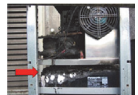
Bild 6: Kontaktierungsproblem bei Klemme
