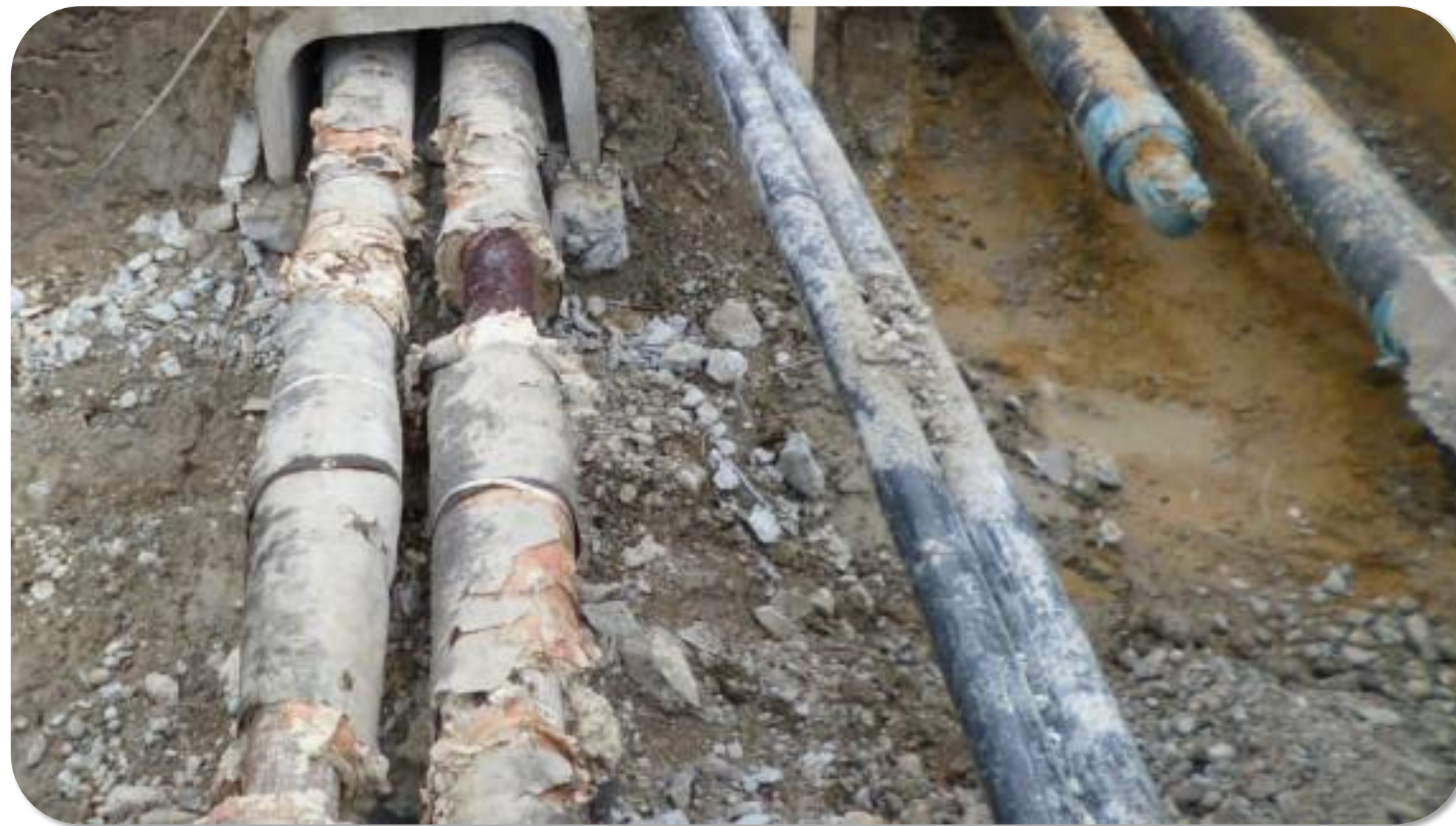
Abbildung 7: Grabung zur Leckageortung [Quelle: Augsburger-Allgemeinde.de]
