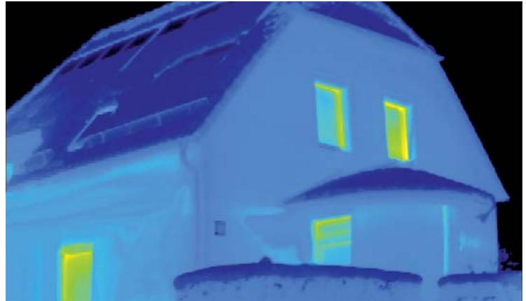
Bei der Thermografie von außen zeigt die gut gedämmte Gebäudehülle des beheizten Hauses keine Auffälligkeiten.
